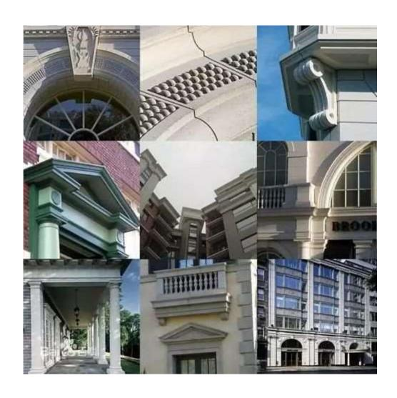
玻璃纖維增強混凝土 (Glass fiber Reinforced Concrete) 又名 GRC,是以耐鹼玻璃纖維作增強材,硫鋁酸鹽低鹼度水泥為膠結材並摻入適宜集料構成基材,通過噴射、立模澆注、擠出、流漿等生產工藝而製成的輕質、高強高韌、多功能的新型無機複合材料。
