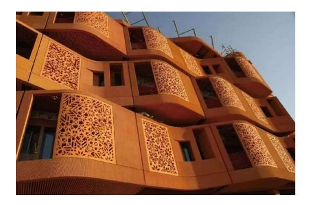
GRC 材料因其成型幾乎不受形狀限制,在現代建築設計中,GRC 建築幕牆越來越多地被設計師應用于大型單曲與雙曲非線性建築設計中,實現其天馬行空的創意效果,最大限度的設計師的形態要求。目前最大單幅可達 20 平米左右。
