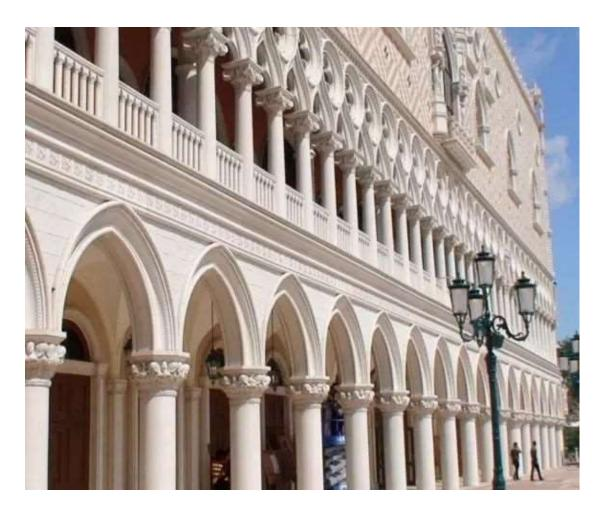
建築裝飾構件是 GRC 運用最多的地方,由於這些年歐陸風情盛行,市場各種 GRC 構件製品,如 GRC 羅馬柱、GRC 簷線、GRC 裝飾線條、GRC 角線、GRC 門窗套、GRC 花 瓶欄杆等。
