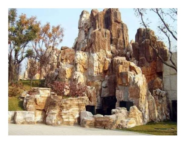
GRC 因其材料自身品質輕,強度高,抗老化且耐水濕,形態易進行工廠化加工,同時其表面通過噴砂、酸洗、噴塗、氟碳漆、仿石漆等各種裝飾工藝,可以高度模仿景觀假山,為假山藝術創作提供了更寬闊的空間和可靠的物質保證。
